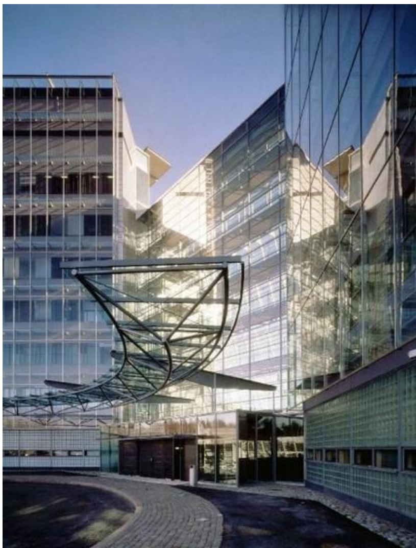
Rys.3. Budynki Firmy Nokia w Helsinkach.
