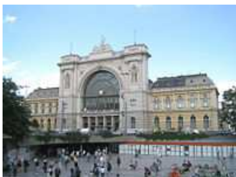
zdjęcie 1 – Dworzec Wschodni
